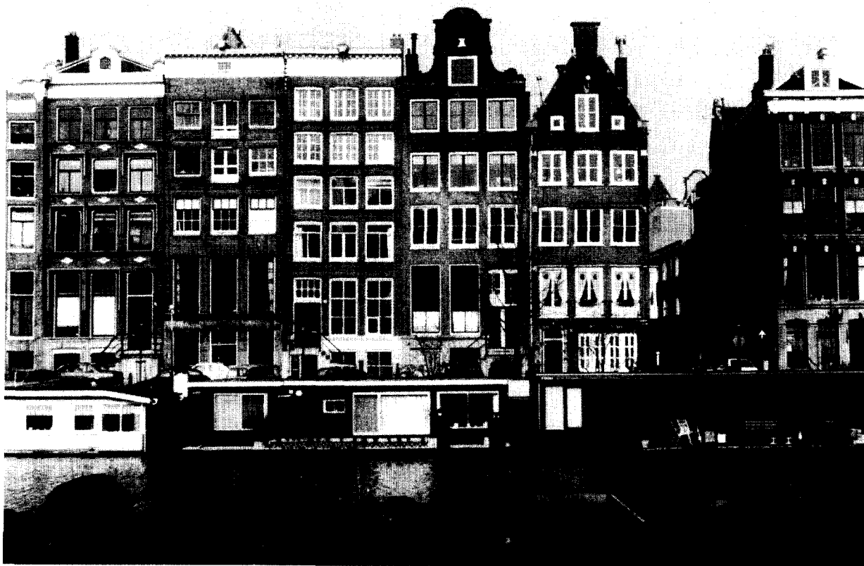
Afb. 1. Binnenkant 29-33 te Amsterdam, anno 1985. Rechts: ingang Schippersstraat (foto auteur).
