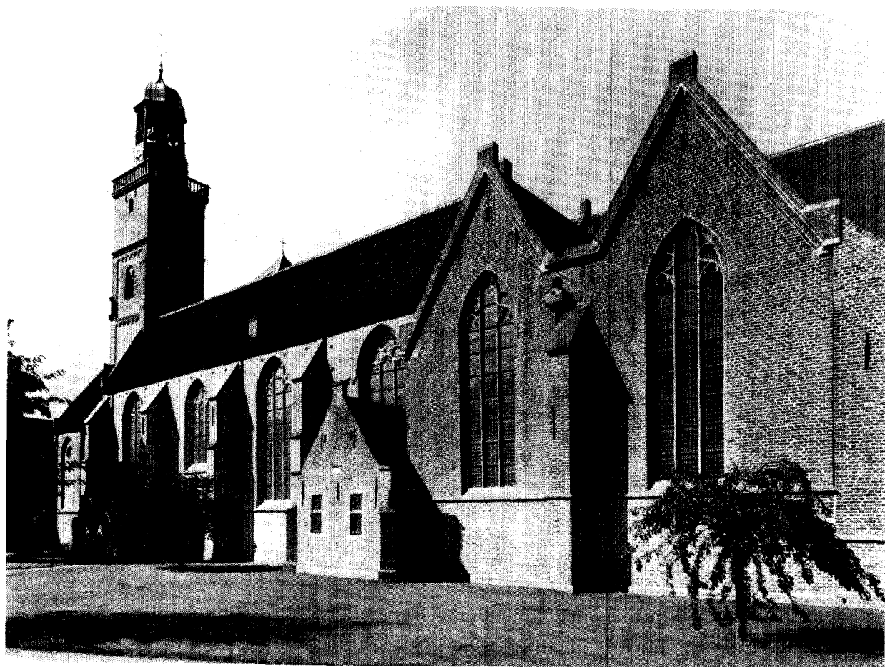
Afb. 9. De zuidzijde van de kerk na de restauratie. Foto uit 1980 (Rijksdienst voor de Monumentenzorg).
