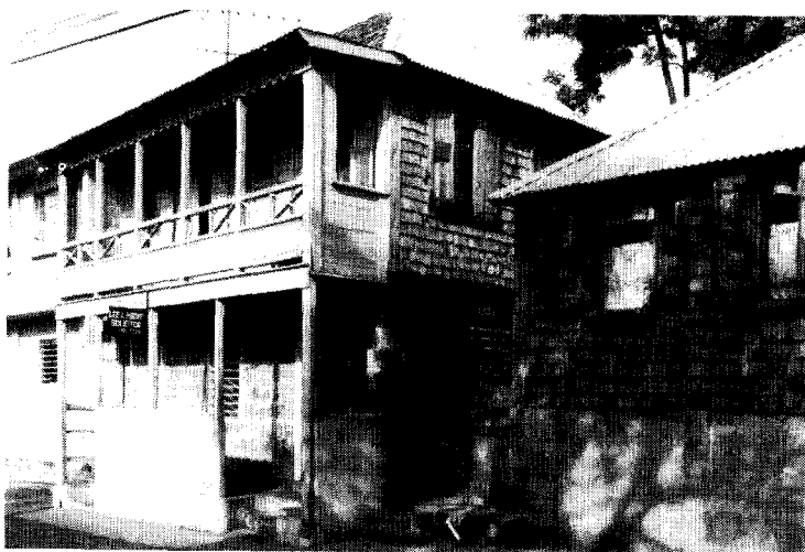
Afb. 6. Een- en tweelaags woonhuizen op (natuur)stenen onderbouw, met een buitenbekleding van houten singels in Basseterre, St. Kitts (foto C. L. Temminck Groll, 1986).
