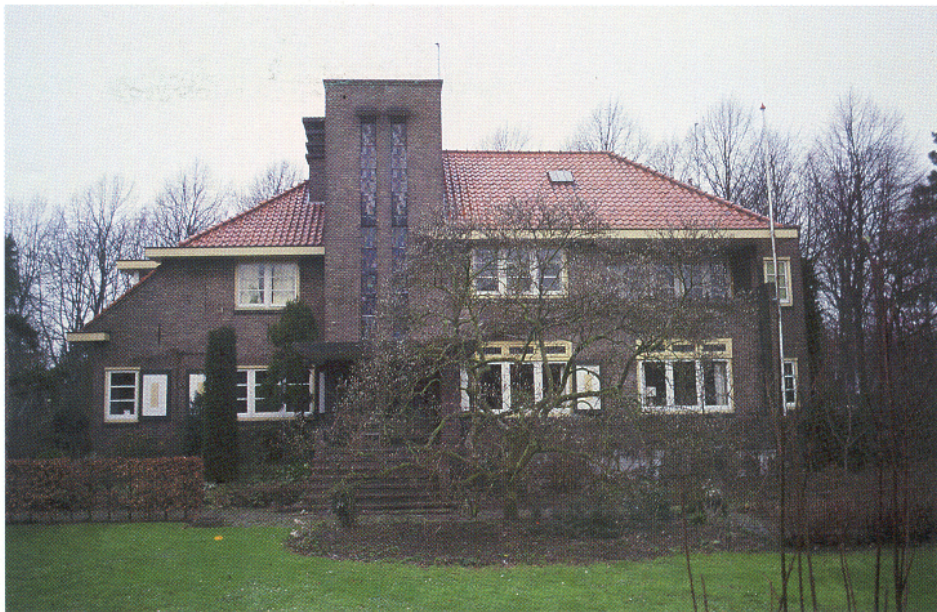
Villa, gebouwd in 1930 door architect D. Visser te Schoonhoven. In het trappenhuis een glas in loodcompositie van V. Huszár. Gemeentelijk monument van jongere bouwkunst te Schoonhoven (foto Th. M. Elsing)
