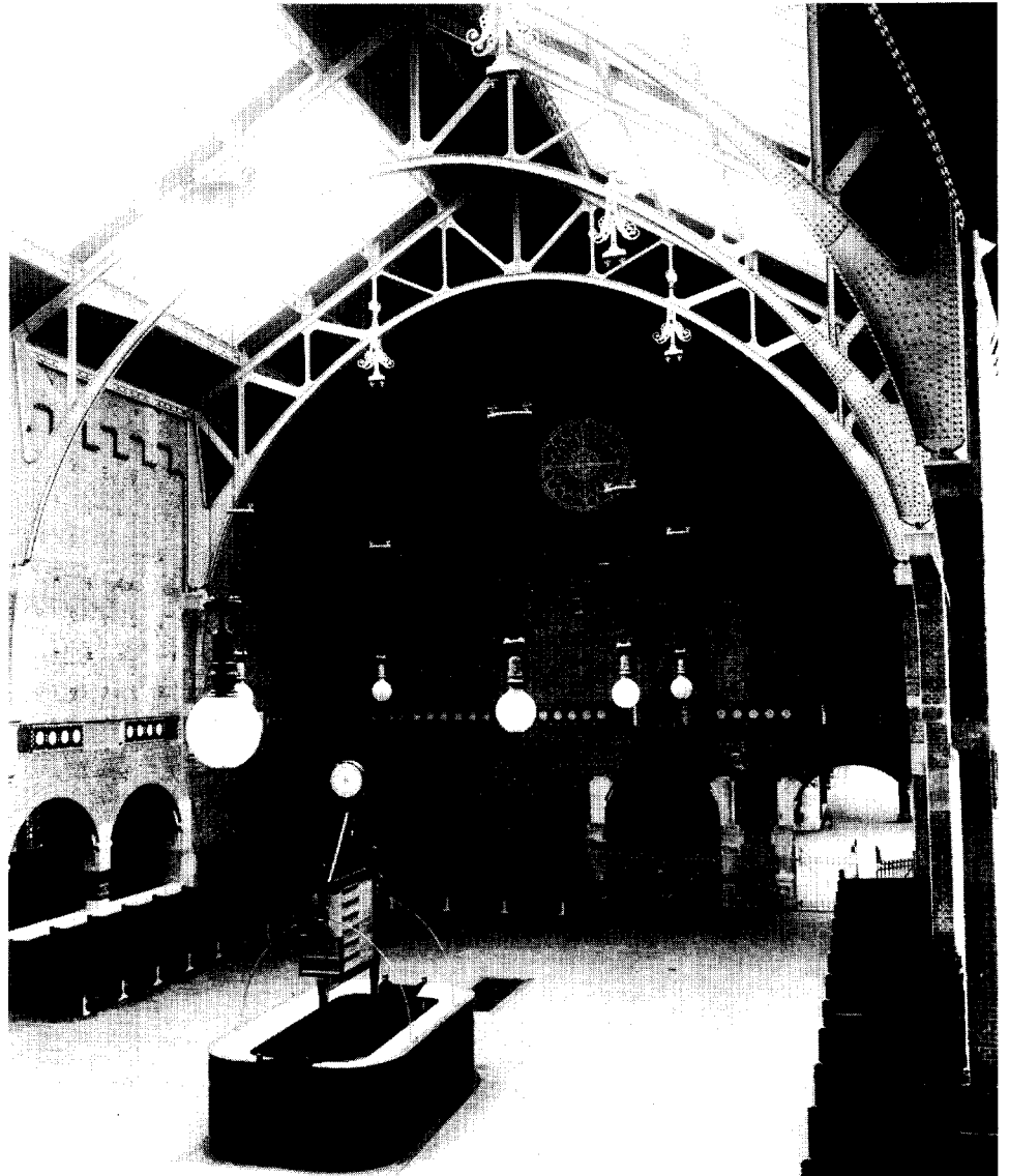
Afb. 2 De Effectenbeurs in haar oorspronkelijke staat. De kopwand zal verdwijnen achter een akoestische 'voorziening', terwijl de boogopeningen alle dicht zijn gezet met glas en een entree-unit (Gemeentelijke Archiefdienst Amsterdam).
