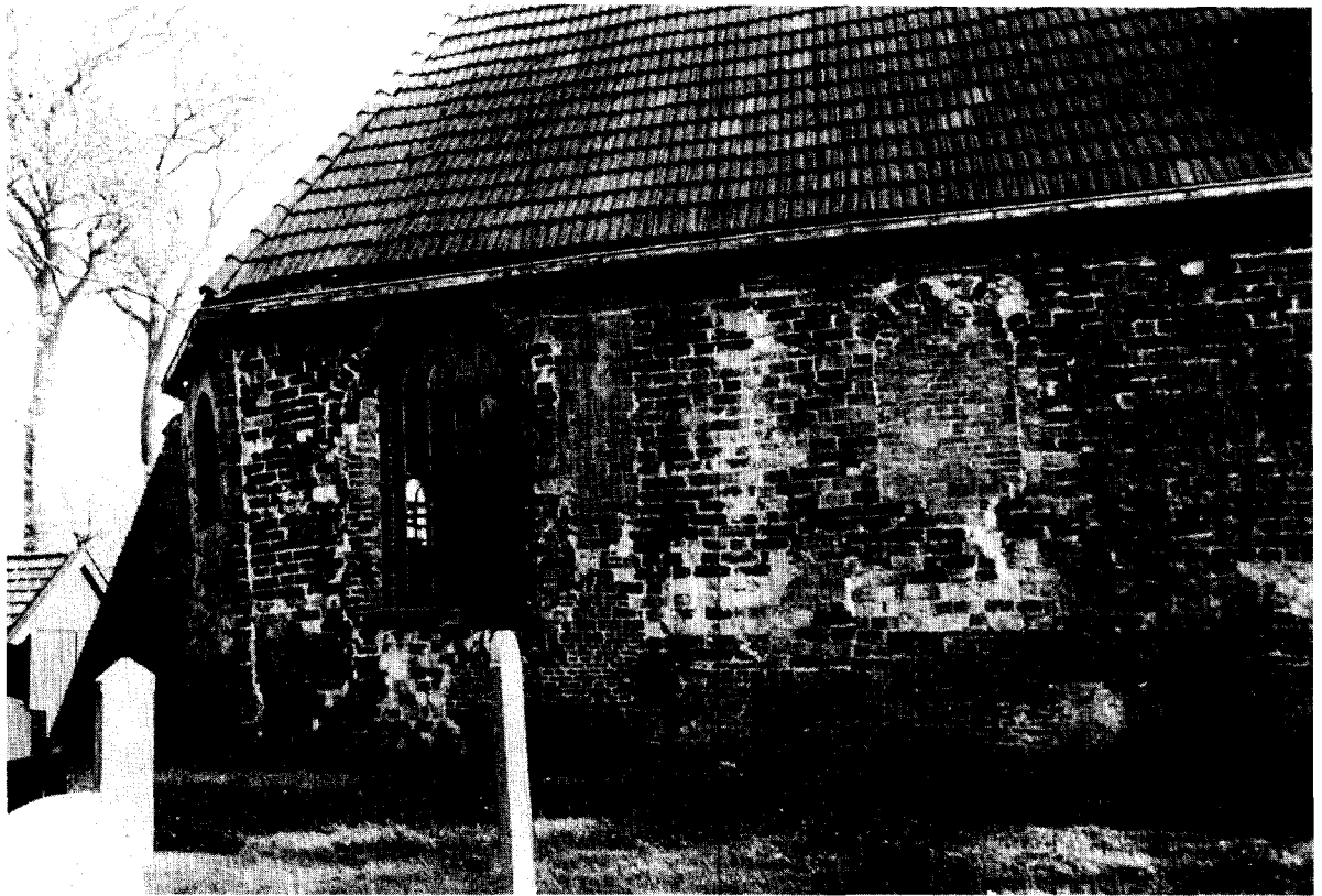
Afb. 3 Detail van de noordgevel, met bouwsporen van de originele romaanse vensters.
