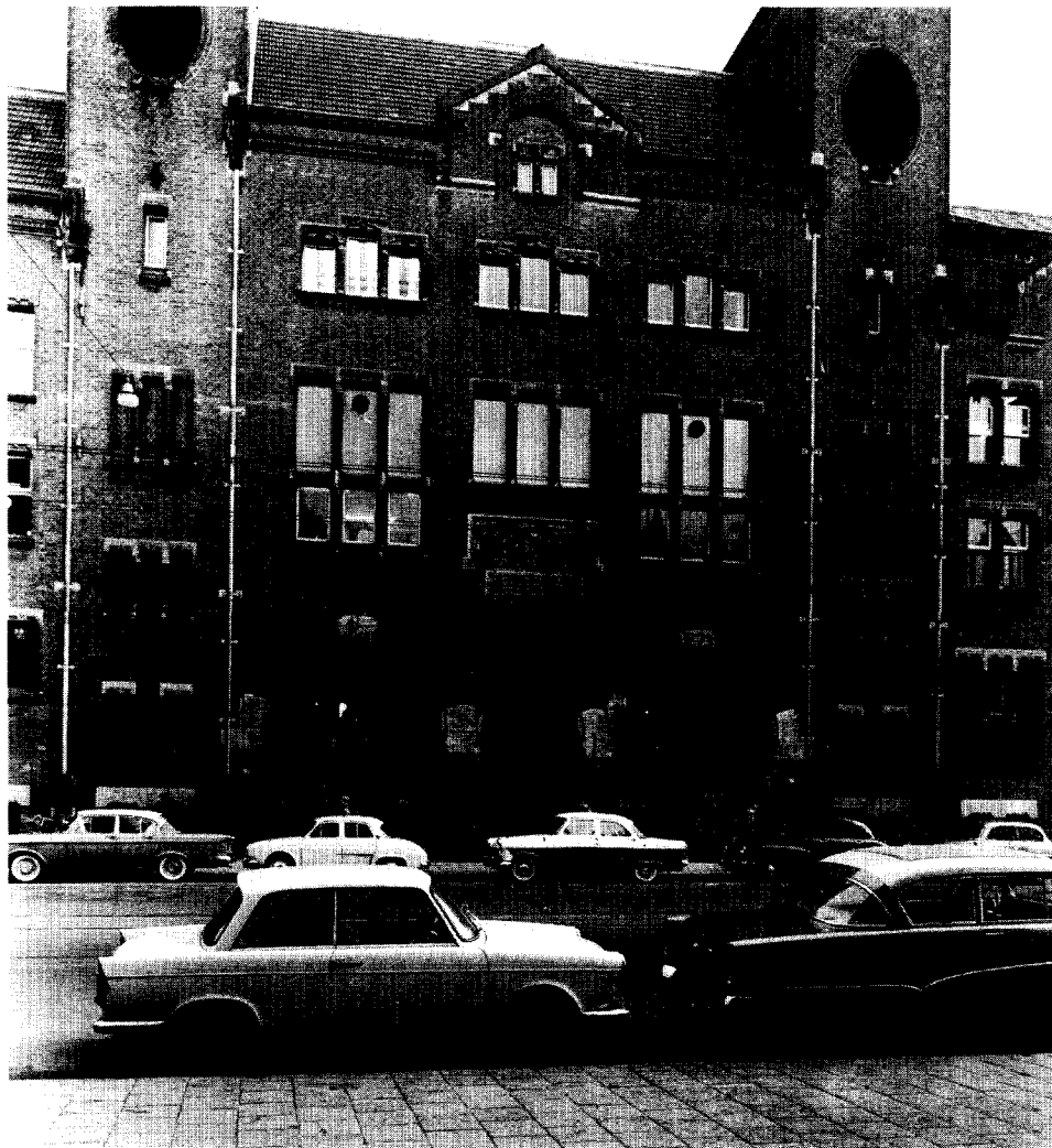
Afb. 5 De entree aan Damrakzijde vóór de wijzigingen van 1960. De trappen, ramen en muurtjes in de boogopeningen hebben toen plaats gemaakt voor een aluminium rolgordijn. Op ca. 50 cm achter de rooilijn komt nu een glaspui met toegangen. Opvallend is dat het trinitasmotief van de entree herhaald wordt in de ontlastingsbogen boven de vensters (Gemeentelijke Archiefdienst Amsterdam).
