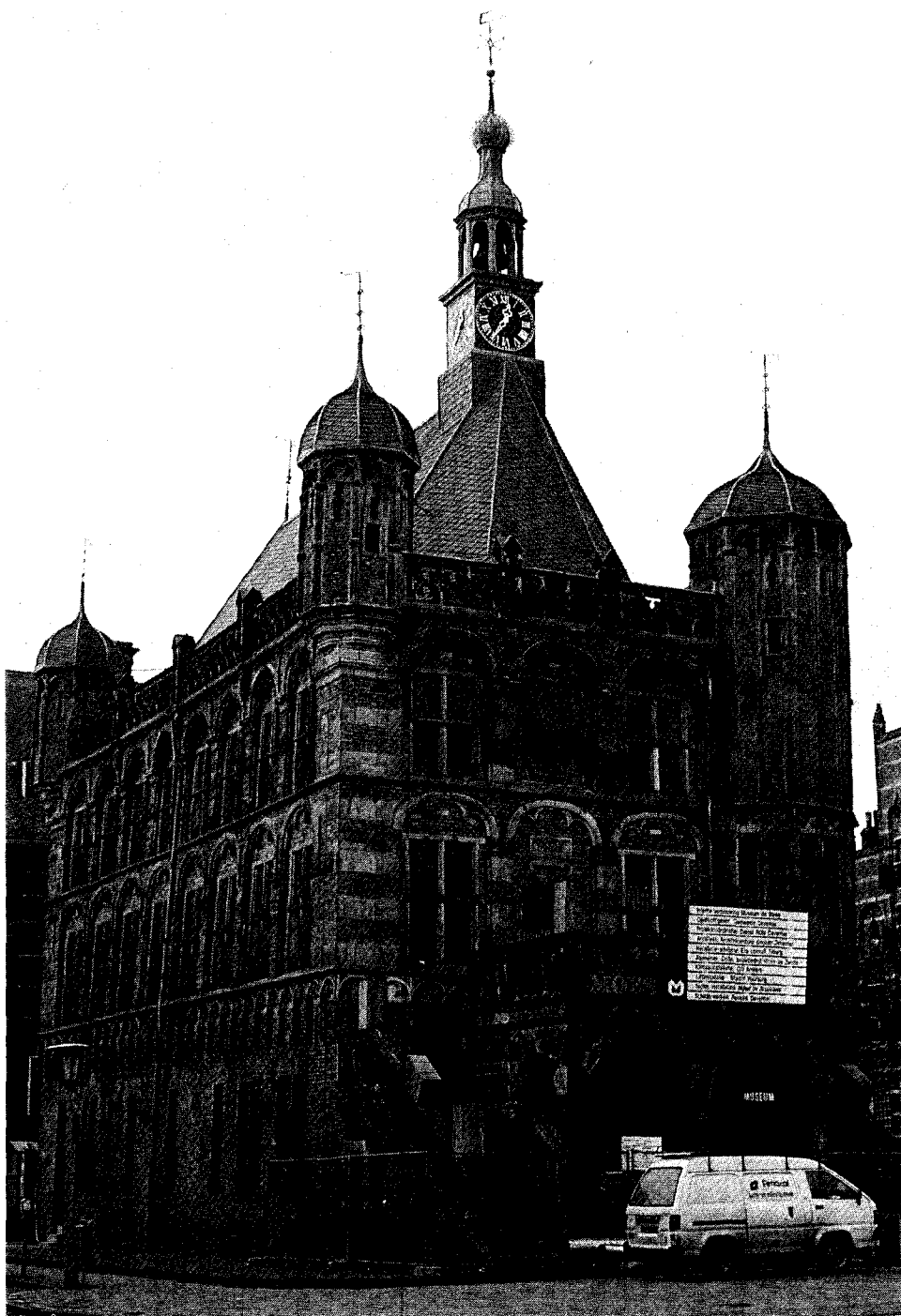
Afb. 1 In september 1987 begonnen de werkzaamheden voor de buitenrestauratie van De Waag (foto Th. M. Elsing).
