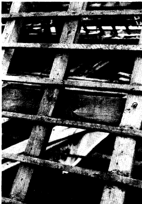
Afb. 12. Merk \Lambda van voorliggende travee, op buitenste spantbeen van spant \Lambda aangetroffen.
