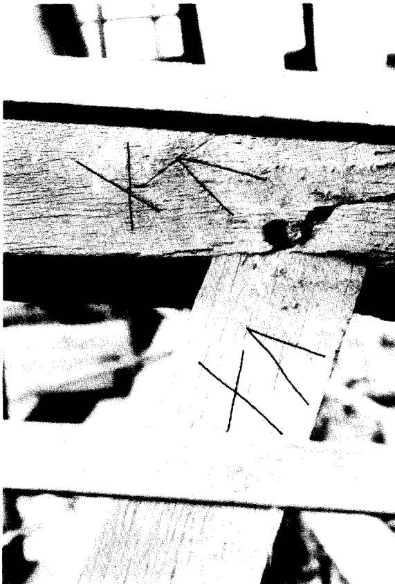
Afb. 15. Telmerk X (15) op schoor en gording van travee A.
