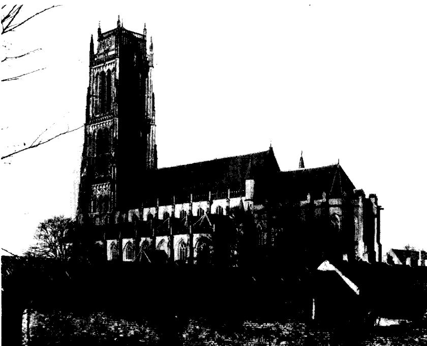
Afb. 7 Zuid-oostzijde van kerk en toren. De schilddakjes op de zijbeuk en de pinakels op de balustrades dateren van de restauratie van 1937-1943, evenals de natuurstenen gotische tracersingen in de vensters van het koor en de zijbeuk (foto RDMZ).
