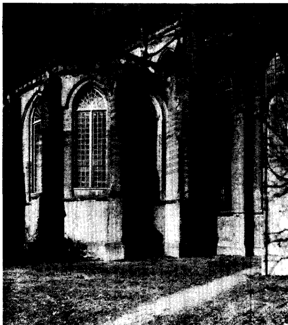
Afb. 8 De oostelijke afsluiting van de zijbeuk. In de vensters zijn nog de houten kozijnen aanwezig, die tijdens de restauratie van 1937-1943 vervangen werden (foto uit 1932, RDMZ).
