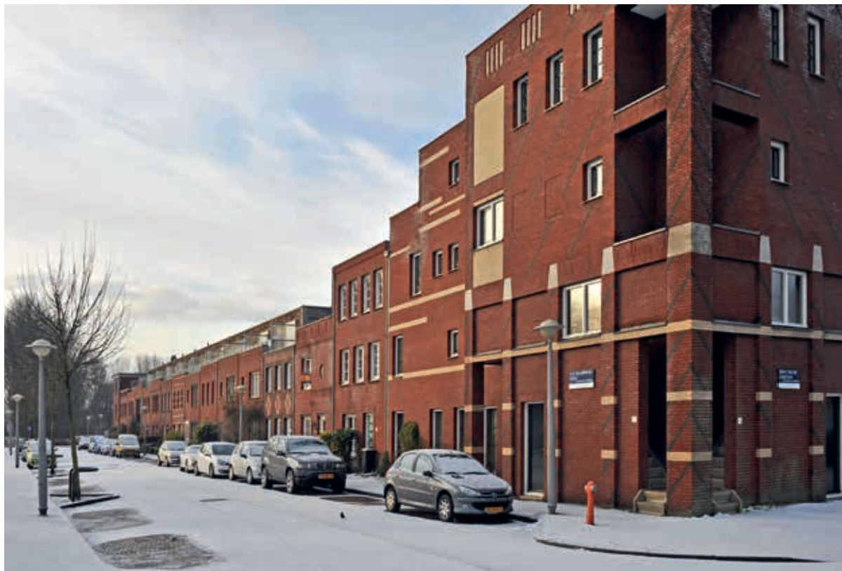
4. Noorderhof, H.M. Kraaijvangerstraat gezien in zuidwestelijke richting naar de Noordzijde vanaf de Dom H. van der Laanstraat (Stadsarchief Amsterdam/ foto Martin Alberts)
