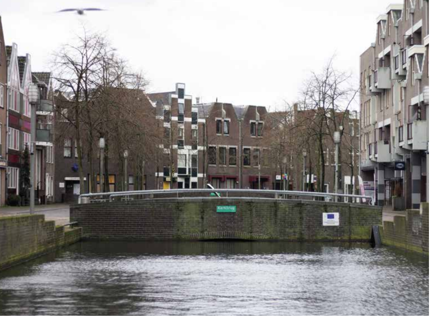
2. Almere Haven kreeg grachtjes en een architectuur die in schaal, materialiteit en vorm moest doen denken aan de historische stadjes aan de Zuiderzeekust (foto Rosa Tigges)
