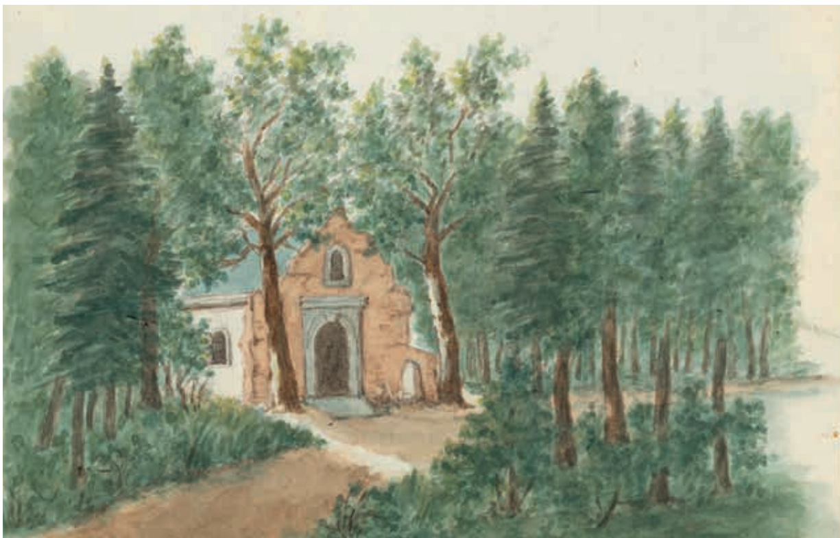
12. De hermitage op Ridderoord bij De Bilt. Getekend door de destijds 76-jarige Maurits Eyck van Zuylichem, eigenaar van de buitenplaats, 1840 (Nationaal Archief)
