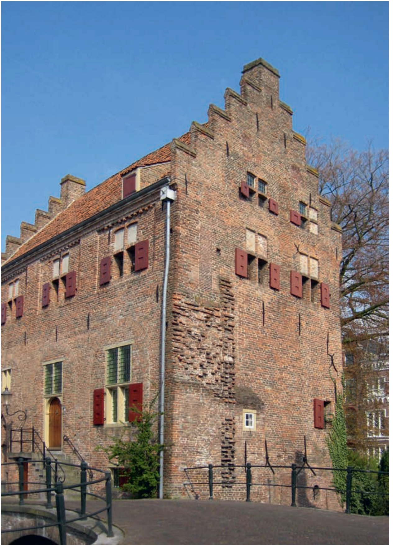
4. Een groot deel van de voorgevel van het muurhuis Tinnenburg werd gevormd door de eerste stadsmuur. Naast het huis bevond zich een van de waterpoorten van de tweede stadsmuur, aan de gevel is nog te zien hoe deze ooit aan dit muurhuis verbonden was (foto auteur)
