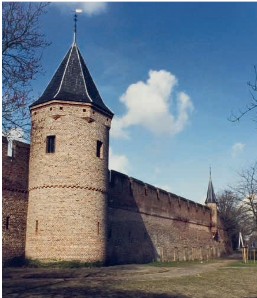
20. Stadsmuur gezien vanuit het Plantsoen Oost ter hoogte van Achter de Kamp. Dit deel van de stadsmuur is een reconstructie en is voorzien van een waltoren en een arkeltoeren (foto Bureau Monumentenzorg, Archief Eemland)
