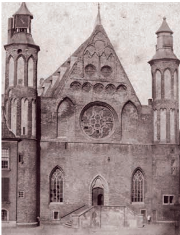
3A. De westgevel van de Grote Zaal in 1860, met de in 1814 aangebrachte tracering van met lood bekleed hout in de twee spitsboogvensters en het roosvenster. De topgevel vertoont de oorspronkelijke steile topgevellijn, die aansluit op de originele kapconstructie. Alleen de schouderstukken zijn opgehoogd (Haags Gemeentearchief)
