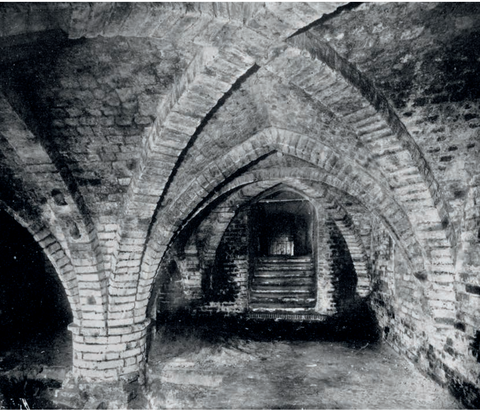
6. De gewelven en een zuil in de middelste kelder (foto W. Kramer, 1899, Nationaal Archief)
