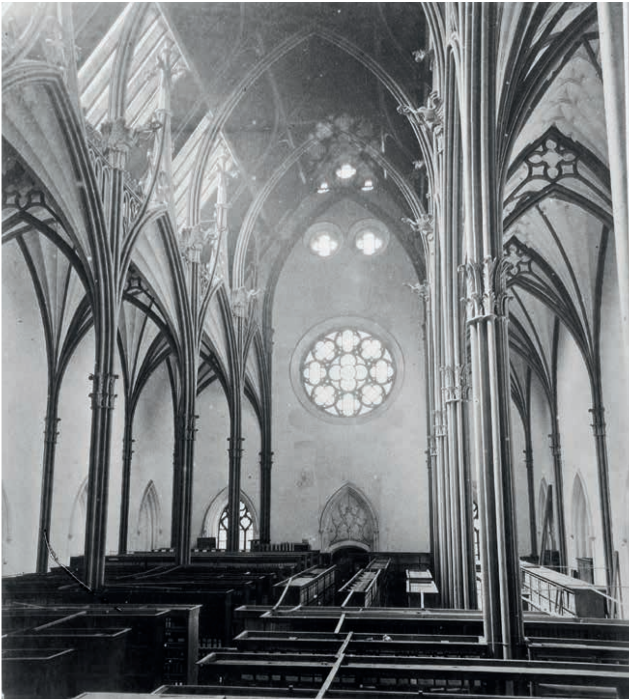
8. De Ridderzaal in gebruik als archiefruimte, met de gietijzeren kap uit 1861 (foto Rijksdienst voor het Cultureel Erfgoed)
