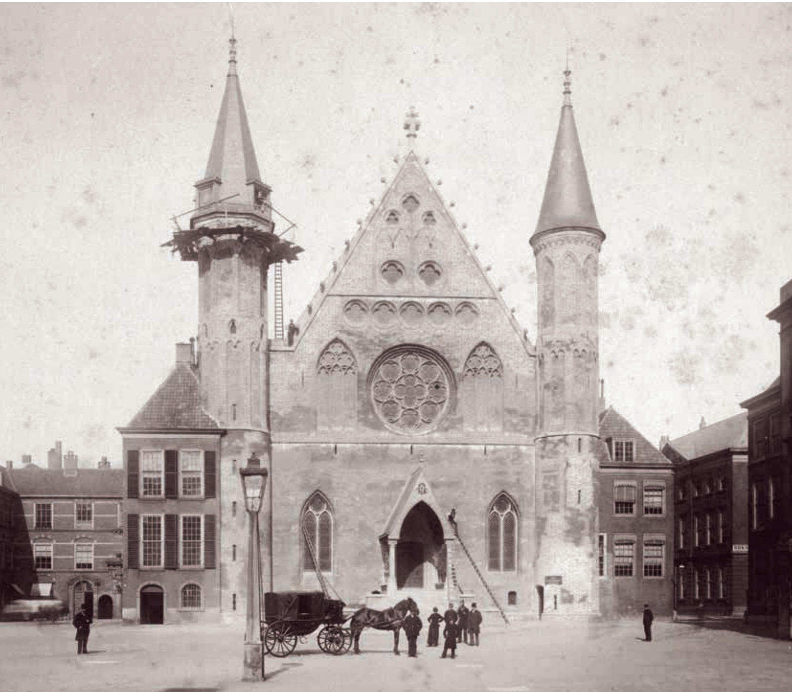
6. De westgevel van de Grote Zaal gedurende de afrondende restauratiewerkzaamheden in 1880. De gerestaureerde 'middeleeuwse' geveltop volgt de daklijn van de gietijzeren kapconstructie uit 1861. Hierdoor heeft de topgevel een groter bouwvolume gekregen en heeft de gevellijn een flauwere helling dan de oorspronkelijke middeleeuwse topgevel (Haags Gemeentearchief)
