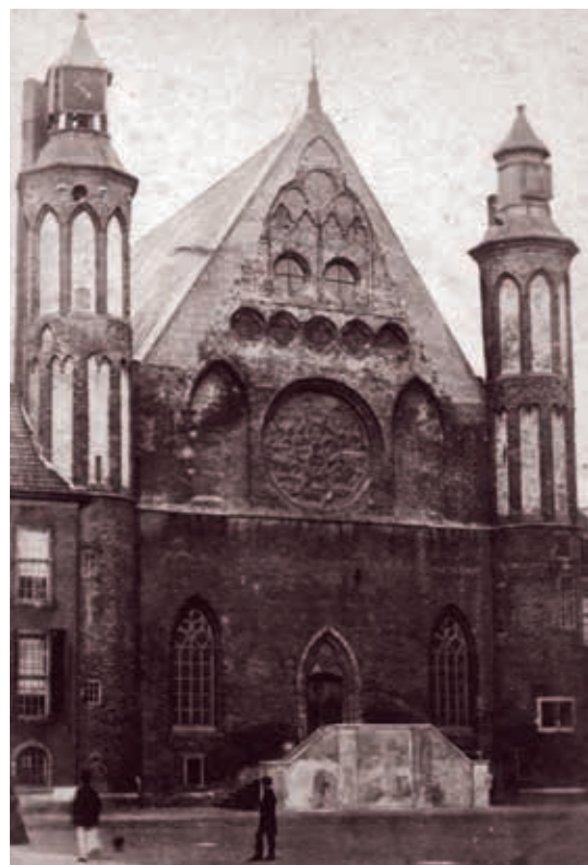
3B. De topgevel in 1865, na vervanging van de houten kapconstructie uit 1295 door een gietijzeren constructie door rijksbouwmeester Rose in 1861. Omdat deze nieuwe kapconstructie een andere dakhelling heeft, is de topgevel daarop aangepast door het aanbrengen van nieuw metselwerk in een afwijkende baksteen, dat vrij grof is ingetand in het originele middeleeuwse metselwerk (Haags Gemeentearchief)
