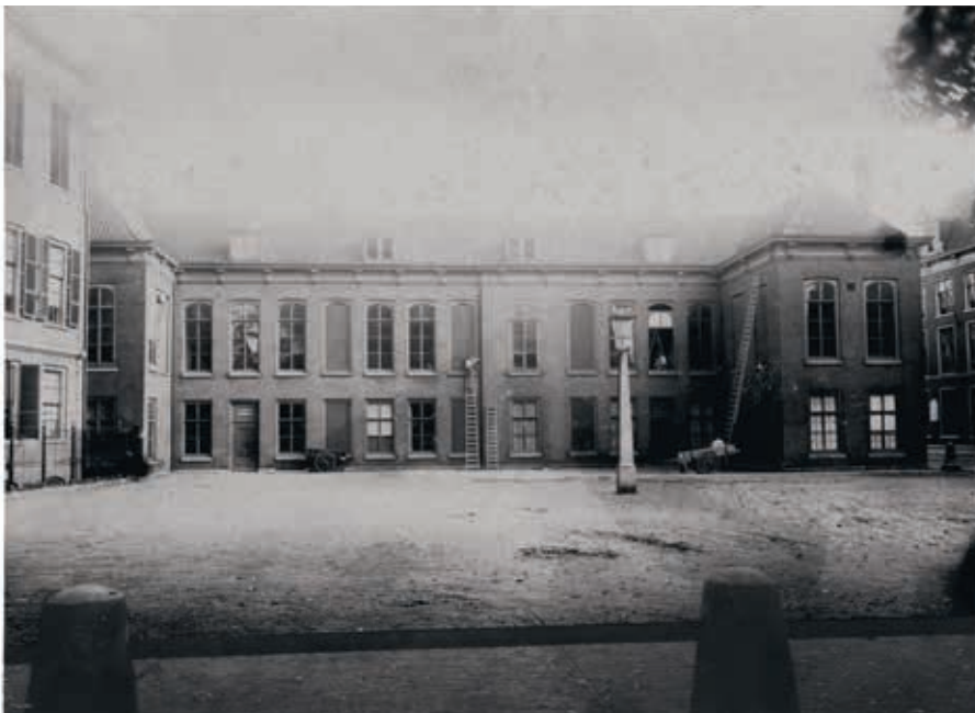
6. Het rond 1690 gebouwde en rond 1730 verbouwde Hof van Albemarle op het Buitenhof met links de zuidwesthoek van het nieuwe stadhouderlijk kwartier en op de voorgrond het plein waar zich de Prinsentuin bevond, kort voor de sloop in 1915 (Haagse Beeldbank)
