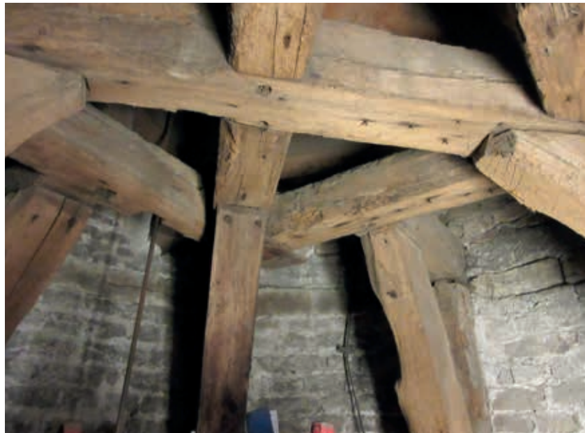
8. Bovenste horizontale raamwerk van het tafelment in de noordwestelijke toren van de Grote Zaal. Op de balken zijn getrokken telmerken herkenbaar. Het in eikenhout uitgevoerde tafelment is in 1295 tot stand gekomen en droeg oorspronkelijk de torenspits (foto H. Hundertmark, 2021)
