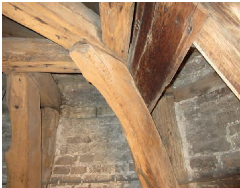
11. Detail van het bovenste horizontale raamwerk van het tafelment in de noordwestelijke toren van de Grote Zaal. De balken van dit raamwerk zijn opgelegd en ingekeept in een rondlopende muurplaat. Deze muurplaat heeft dezelfde ronding als het gevelmetselwerk van de ronde torengewel (foto H. Hundertmark, 2021)
