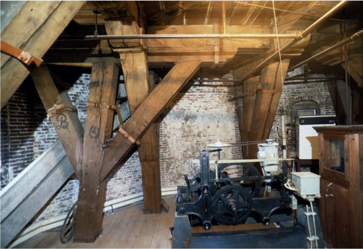
12. Amsterdam, Montelbaanstoren: achttiende-eeuwse steunconstructie voor de houten bekroning, opname 2006 (Han van Gool/Monumenten en Archeologie Amsterdam)
