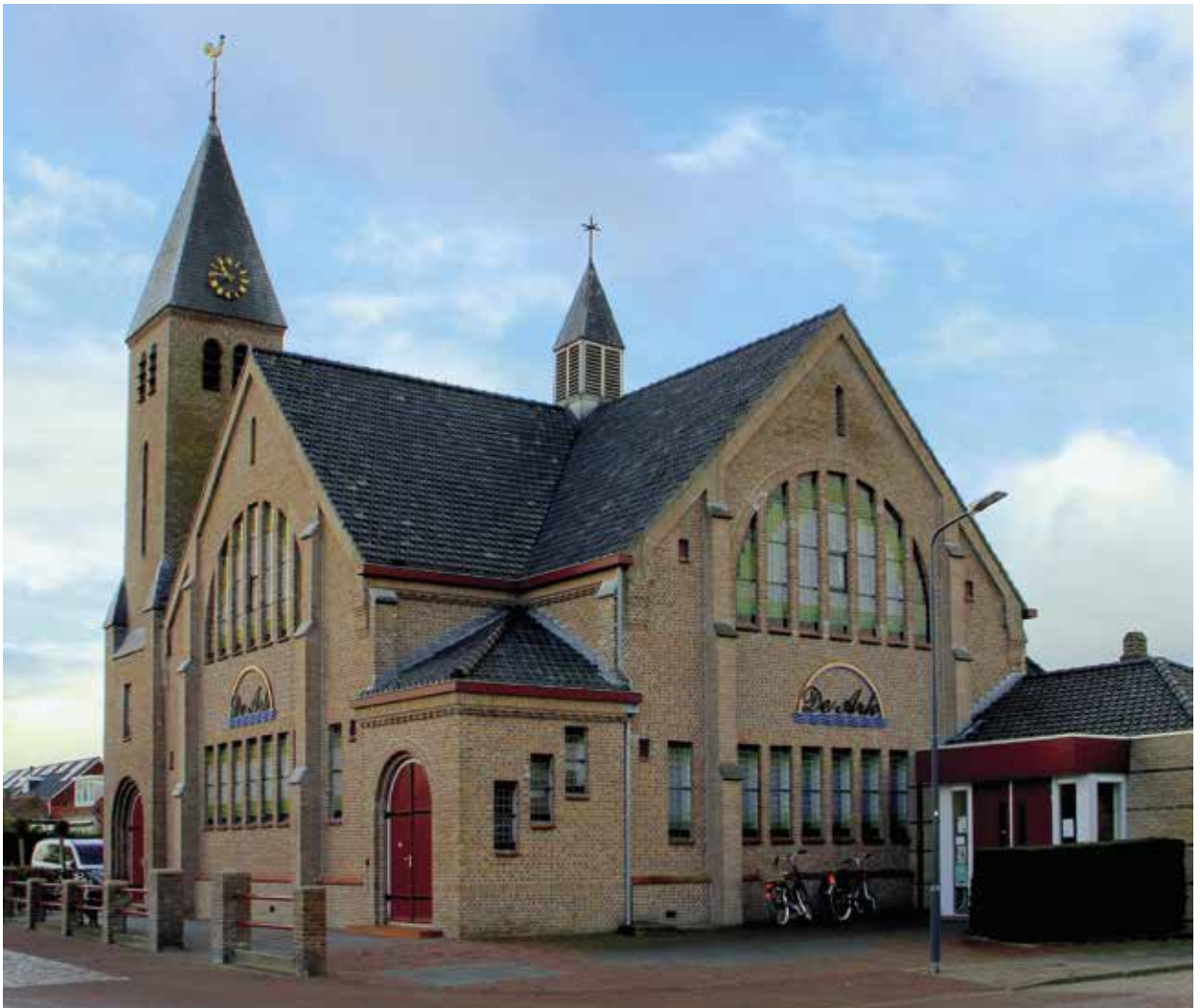
12. P.S. Dijkstra, Gereformeerde Kerk aan de Veerweg in Kamperland, tegenwoordig De Ark (foto Marieke Kuipers, 2022)
