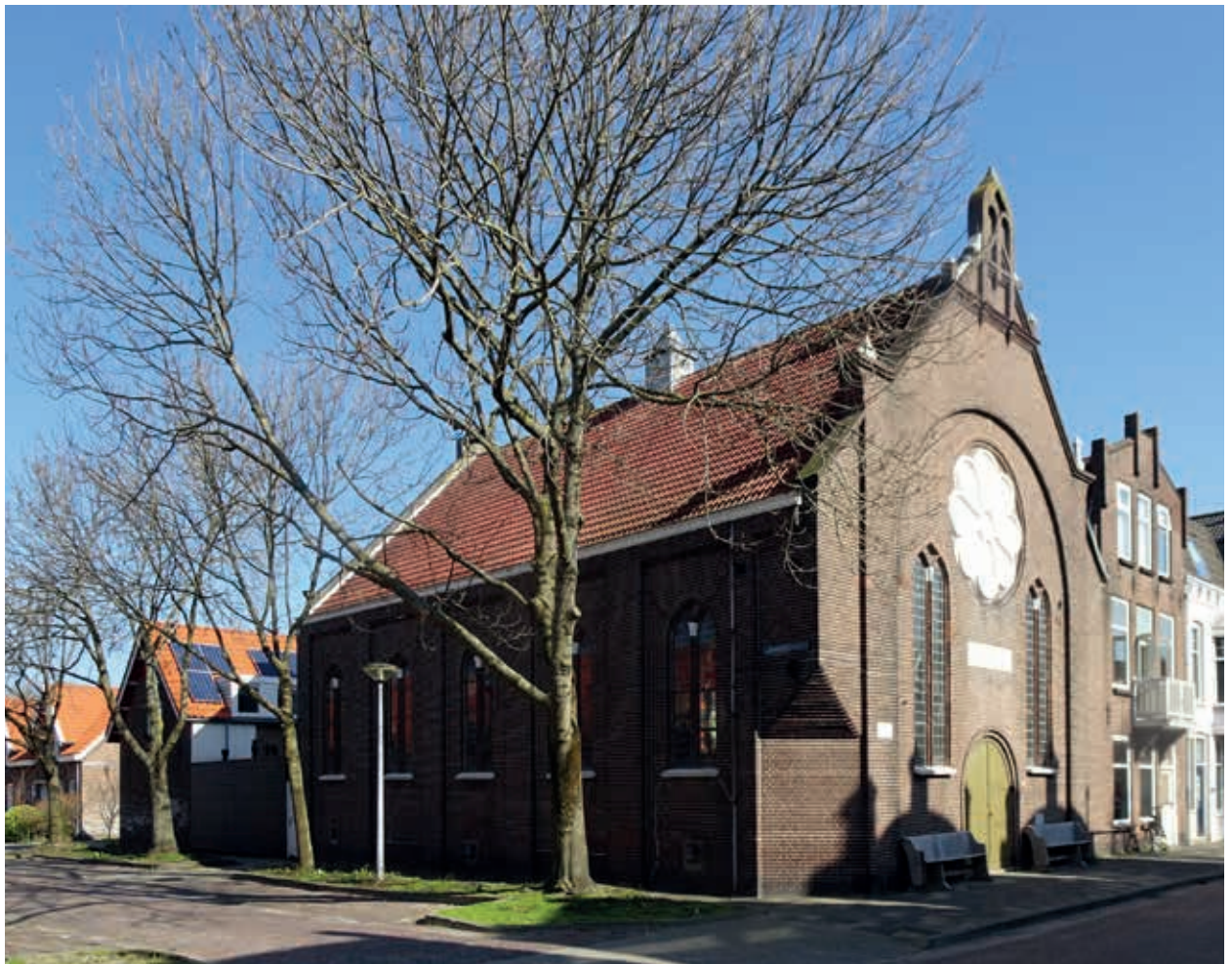
5. P.S. Dijkstra, Gereformeerde Kerk Eben Haëzer op de hoek van de Kasteelstraat en de Lammensstraat in Vlissingen. Links op de achtergrond gerenoveerde woningen van de 'Rode Buurt' (foto Marieke Kuipers, 2021)
