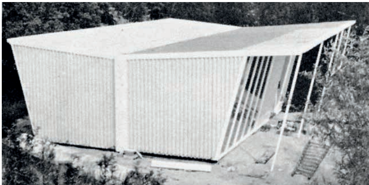
3. Wim Pijpers, kunststof woning, vanaf 1962 geproduceerd door de firma Frits Bode bouwplastic n.v. (Bouw 18 [1963] 51)
