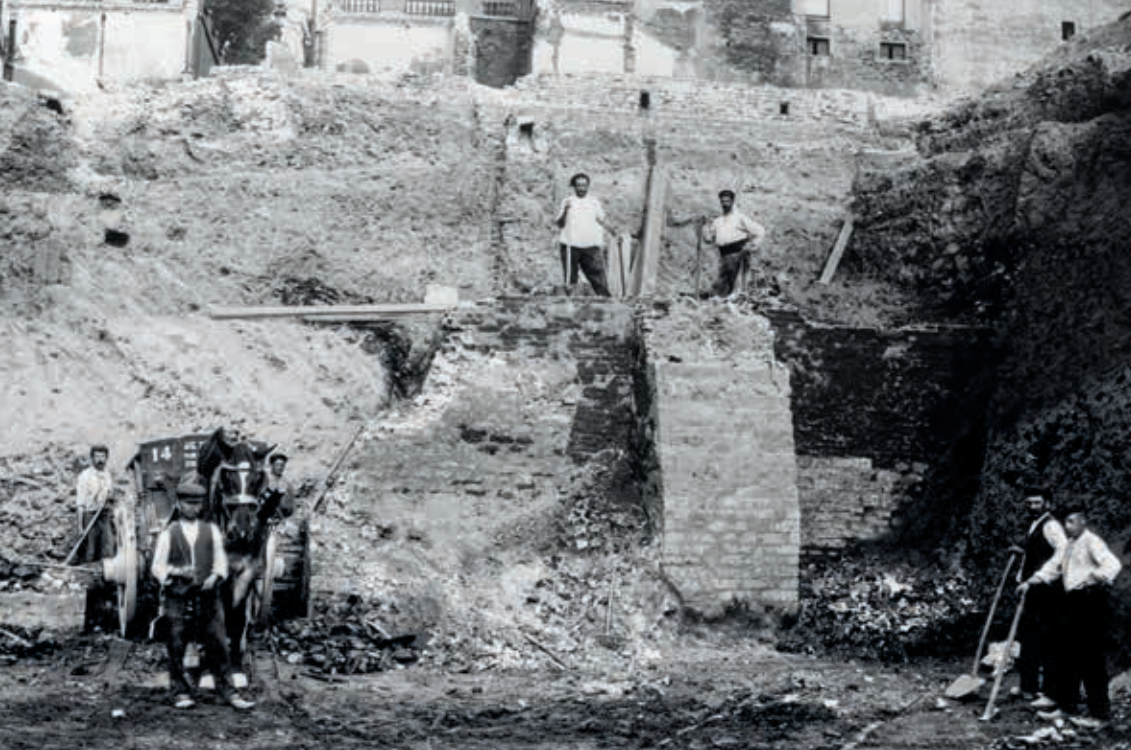
△ Afbraakwerken voor de Noord-Zuidverbinding in de rue d'Isabelle in 1911. Foto uit de collectie van het Comité d'Etudes du Vieux Bruxelles (KIK-IRPA, Brussel)
