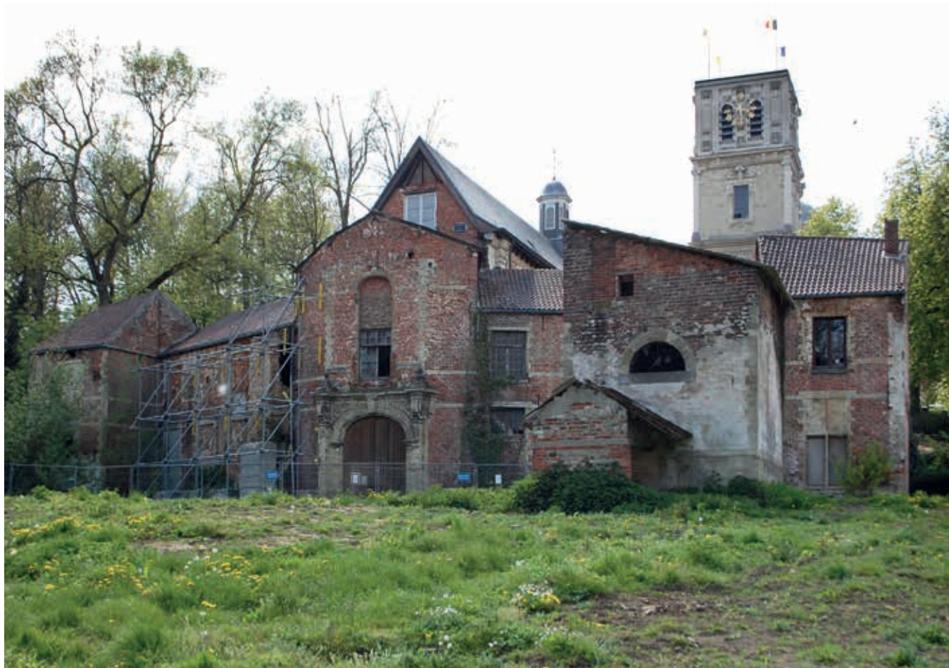
15. De in bouwvallige staat verkerende westvleugel van de residentie van de oratorianen (foto auteurs)
