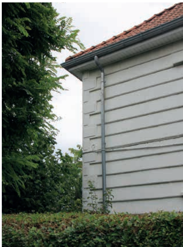
5. De meeste alternatieve bouwsystemen maakten gebruik van betonblokken. Sommige betonblokken worden gekenmerkt door een opvallende vormgeving of profilering, zoals het systeem Skoetz-Beving (links). Bij vele andere systemen, zoals het systeem Levie (rechts), werd een egaliserende pleisterlaag aangebracht zodat de unieke vorm pas zichtbaar wordt bij renovatiewerken (foto's Ine Wouters, 2024)
