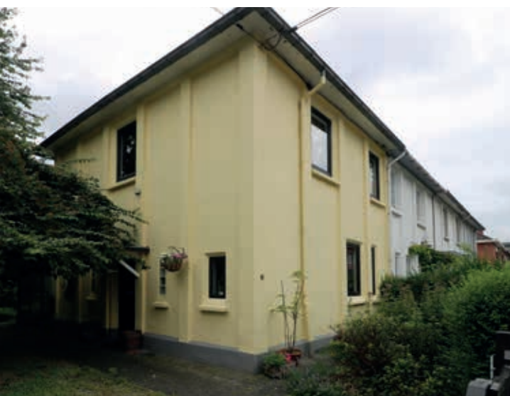
6. In Het Rad werden drie skeletsystemen toegepast; enkel bij de systemen Kent (links) en Baudoux (rechts) tekent het skelet zich duidelijk af in de gevel (foto's Ine Wouters, 2024)
