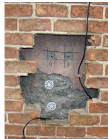
16. Een zicht op de woningen aan het Kardinaal Mercierplein, in originele toestand (1925) en na de plaatsing van de voorzetwand in metselwerk (foto 2015). Bij onderzoek naar de erfgoedwaarde van deze woningen door het bureau Fenikx werd een deel van het metselwerk verwijderd, om zo de toestand van de originele betonstructuur en de donkerrode cementbepleistering te kunnen beoordelen (Sint-Lucasarchief, collectie Hoste nr. 157 (boven); foto's Ann Verdonck, 2015 (onder))
