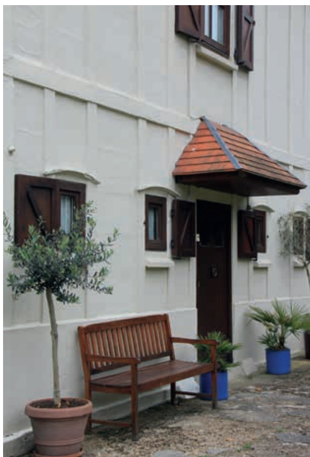
5. De meeste alternatieve bouwsystemen maakten gebruik van betonblokken. Sommige betonblokken worden gekenmerkt door een opvallende vormgeving of profilering, zoals het systeem Skoetz-Beving (links). Bij vele andere systemen, zoals het systeem Levie (rechts), werd een egaliserende pleisterlaag aangebracht zodat de unieke vorm pas zichtbaar wordt bij renovatiewerken (foto's Ine Wouters, 2024)
