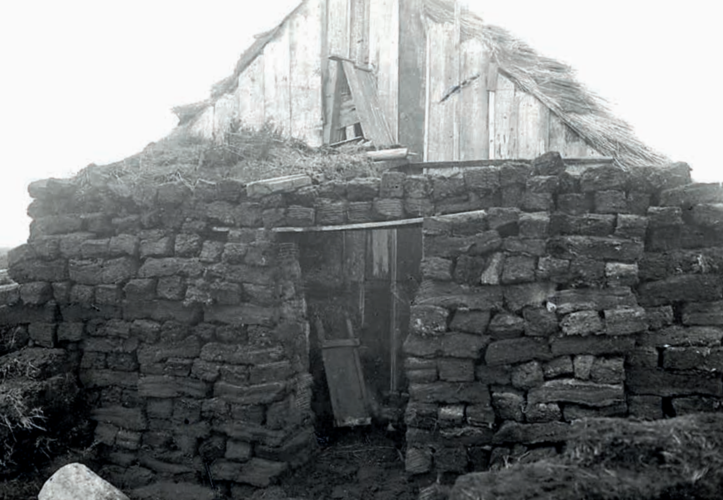
8. Een plaggenhut zoals aan het begin van de twintigste eeuw nog kon worden aangetroffen. De forse blokken zijn gestapeld in een slordig Vlaams verband (foto Nationaal Archief/Collectie Spaarnestad/Het Leven/fotograaf onbekend)
