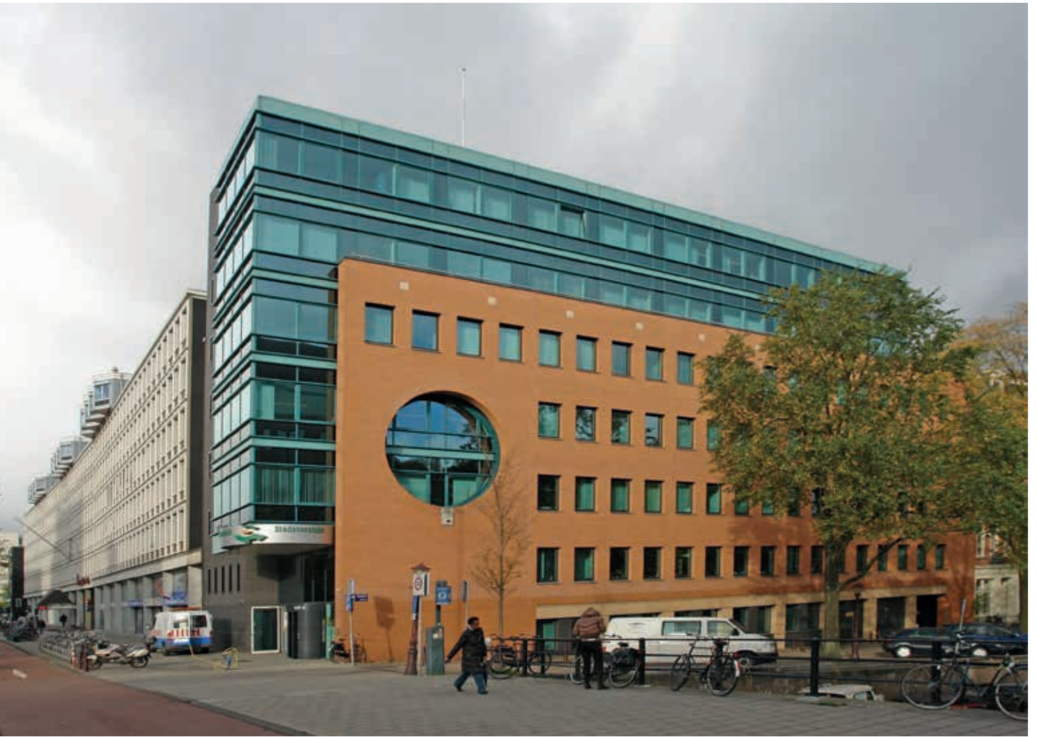
7. Nieuwbouw van De Jong Hoogveld De Kat ter plaatse van de gesloopte gebouwen van Rood, Ouëndag en Staal. Foto Martin Alberts, 2006 (Stadsarchief Amsterdam)
