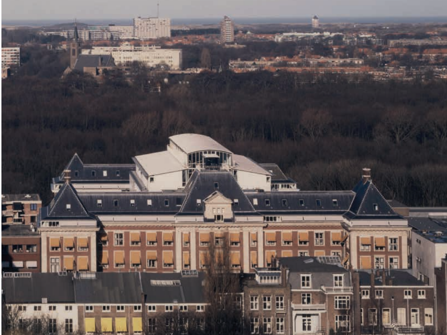
9. De dakopbouw van drie verdiepingen op de twee middenvleugels van Ruijssenaars uit 1993, met in het midden de iets hogere overkapping van het atrium. Foto Oerlemans van Reeken Studio, 1994 (Haags Gemeentearchief)
