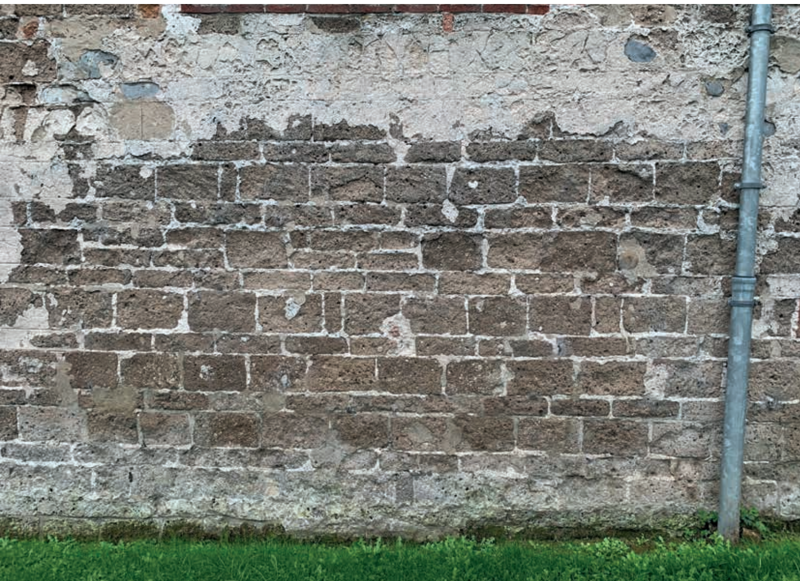
14. Klamp-ankerwerk in de Nederlands Hervormde kerk van Goutum (foto auteur, 2023)
