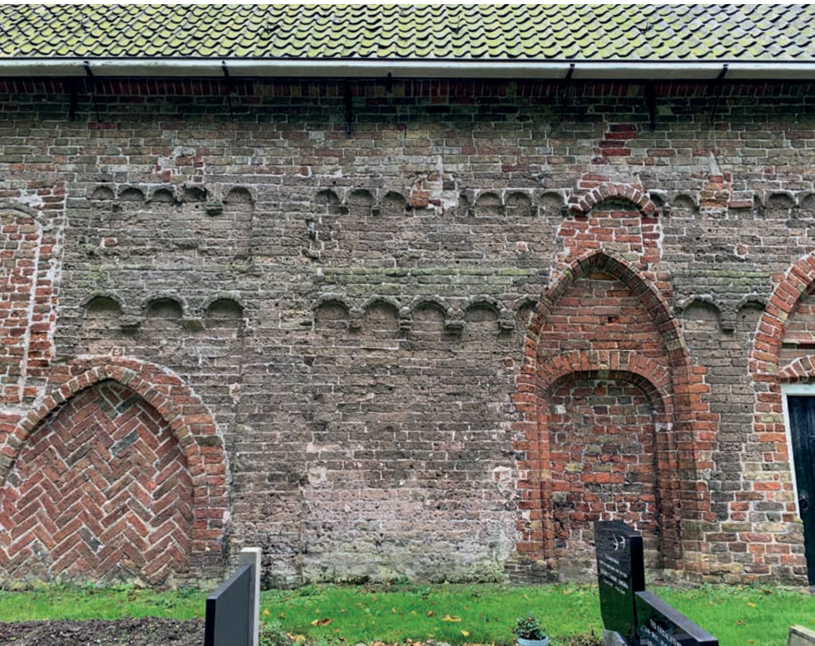
12. In het werk bijgehakte lisenen van tufsteen in de kerk van Jelsum (foto auteur 2023)
