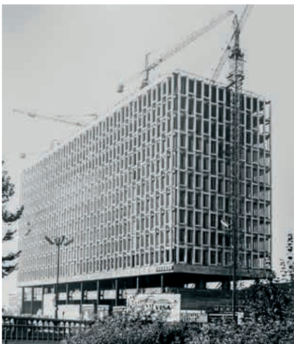
8. Montage van de geprefabriceerde betonnen gevelkaders door aannemer Herpain, november 1967 en oktober 1968. De gevelelementen dragen bij aan de verticale en horizontale stabiliteit in tegenstelling tot de 'klassieke' glazen vliesgevel (Algemeen Rijksarchief, Brussel)
