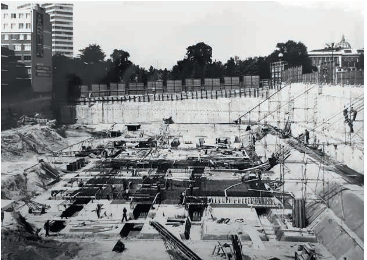
7B. Bouw van de ondergrondse parkeergarage uitgevoerd met de diepwandtechniek, 1966. Zicht op de bouwput tijdens de laatste fase van de funderingswerken (Algemeen Rijksarchief, Brussel)
