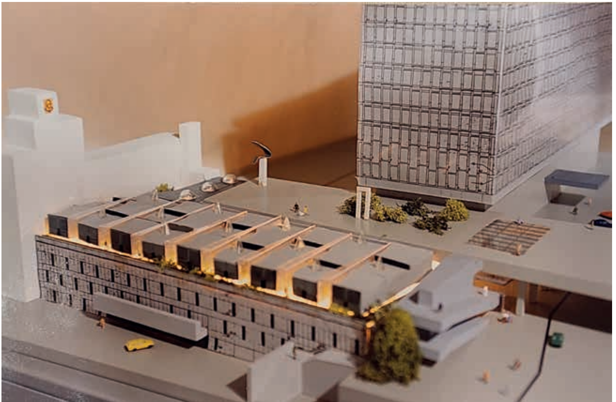
12. Werkmaquette van het nieuwe personeelsrestaurant op de parkeergarage langs de Ommegangstraat, 1992. De rechte dakvlakken zouden in een later ontwerp worden vervangen door afwisselend convexe en concave dakvlakken (Algemeen Rijksarchief, Brussel)
