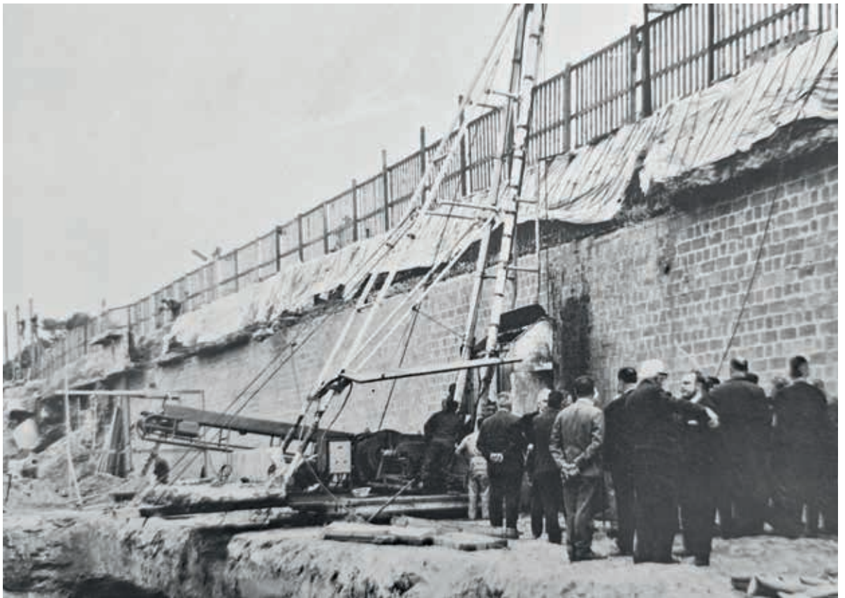
7A. Bouw van de ondergrondse parkeergarage uitgevoerd met de diepwandtechniek, 1966. De techniek werd hier voor het eerst in België toegepast (foto M. Van Audenhove)
