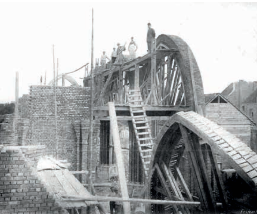
12. Inspectie van valbescherming op werven.
