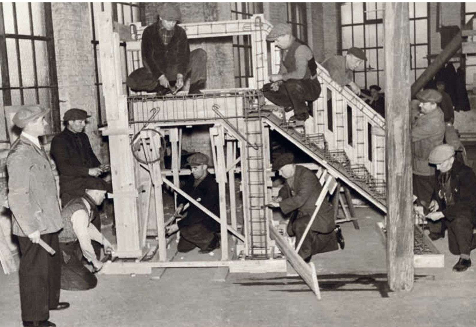
14. 'Herscholen van arbeiders: Het ijzervlechten voor gewapend beton is een voorname zaak in het moderne bouwvak.' Jaren 1930 (AMSAB-ISG, foo14506)
