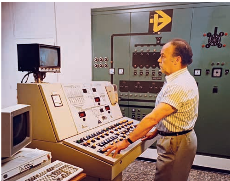
9. Groeiende wetenschappelijkheid in het aanmaken van betonmengsels: let op de grafische weergave van verschillende aggregatensilo's op het mengpaneel. Onderzoek bij Inter-Beton ondersteunde mee de normering van stortklaar beton en het BENOR/SECO-label (Belgisch Rijksarchief, fonds CBR, 3519)
