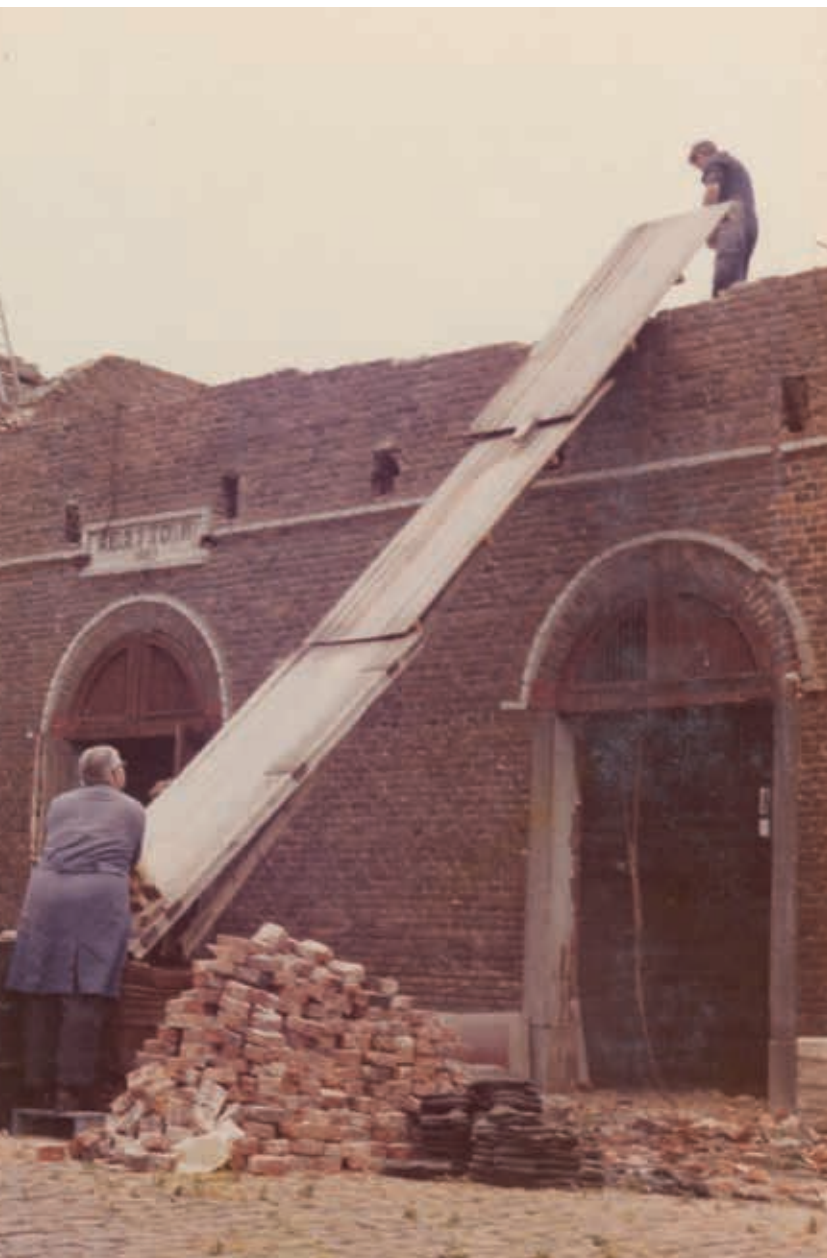
14. Ontmanteling van het voormalige slachthuis van Tienen door de familie Boncher voor de terugwinning van bakstenen en dakpannen (Foto Familie Boncher)
