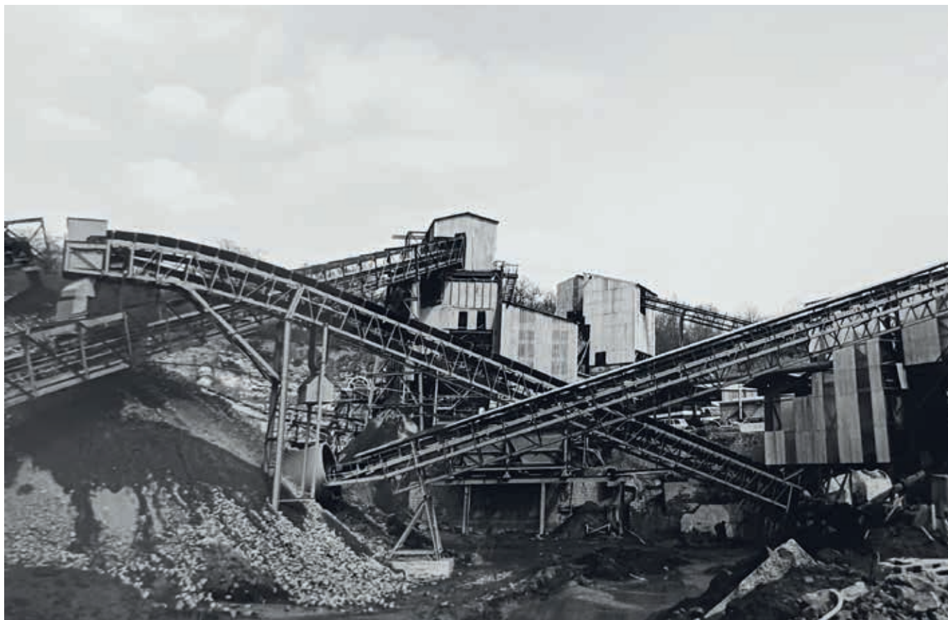
10. Grindwinning door Inter-Beton in Dilsen en Beez in de jaren 1970 (Belgisch Rijksarchief, fonds CBR, 3519)
