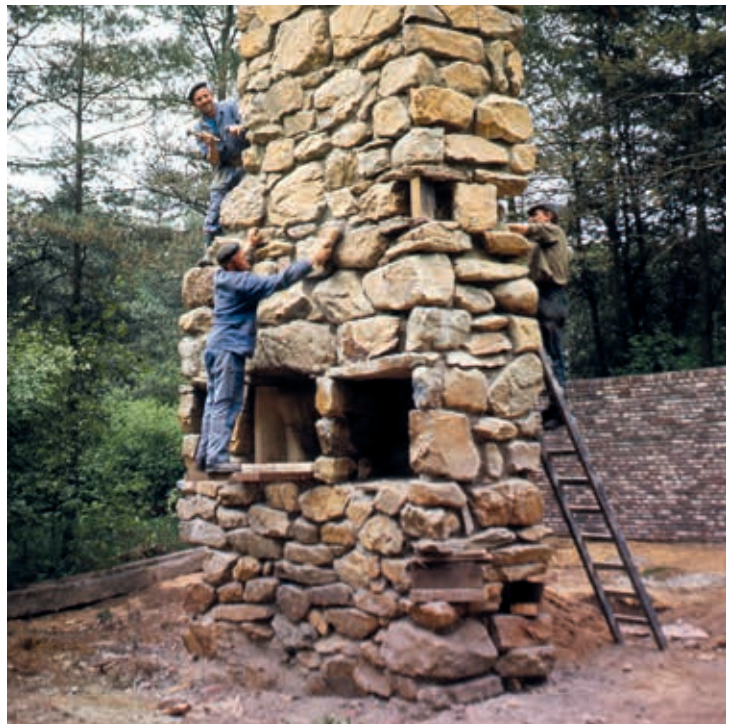
3. Huis Nijsen. De centrale, dubbelhoge sculptuur uit maaskeien is net afgewerkt; de rest van het huis zal eromheen worden gebouwd (Foto Familie Nijsen)
