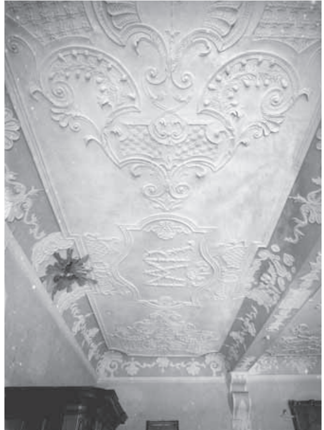
Afb. 5. Meest oostelijke balkvak van de refter in de Roermondse kartuis met centraal de initialen MAR, Maria (foto RDMZ 1926)
