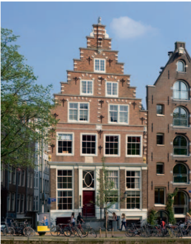
Geldersekaade 97, rond 1600 gebouwd, oorspronkelijke houten pui in de achttiende eeuw gewijzigd, rijksmonument
