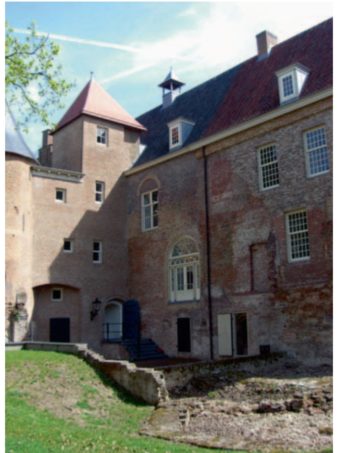
Afb. 3 De huidige voorgevel draagt de sporen van het vroegere gebruik als achtergevel en binnenmuur. De hoofdingang is in de traptoren gesitueerd (Kasteel Nederhemert, Nederhemert-Zuid, april 2008)
