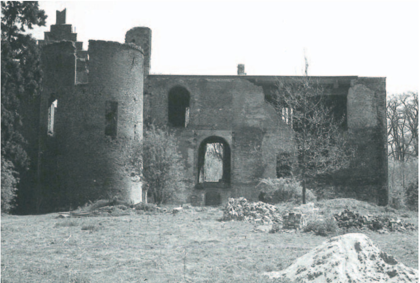
Afb. 2 De voorzijde van kasteel Nederhemert in 1966, nadat de traptoren was ingestort en daarmee een deel van de voorgevel en de ronde toren had meegenomen (foto R. Faber, in J.C. Bierens de Haan en W. Kramer, Kasteel Nederhemert: een eeuwenlang bestaan, Zwolle: Waanders 2005, 43)
