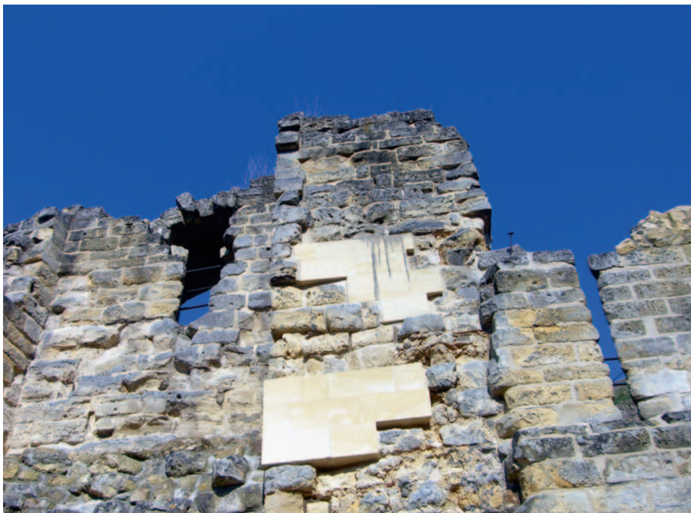
Afb. 10 Een detail van de consolidatie van de ruïne van Valkenburg waaraan thans de laatste hand wordt gelegd (Valkenburg a/d Geul, maart 2010)
