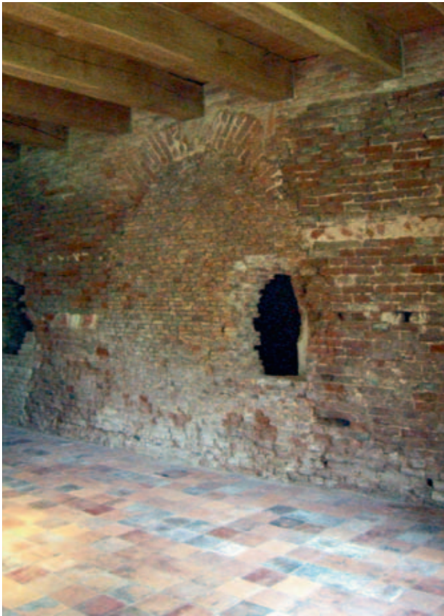
Afb. 4 De muren van de woontoren worden op de verschillende verdiepingen getekend door vele bouwsporen zoals die van de toegang tot een waterput, diverse gevelopeningen en kaarsnissen (Kasteel Nederhemert, Nederhemert-Zuid, april 2008)
