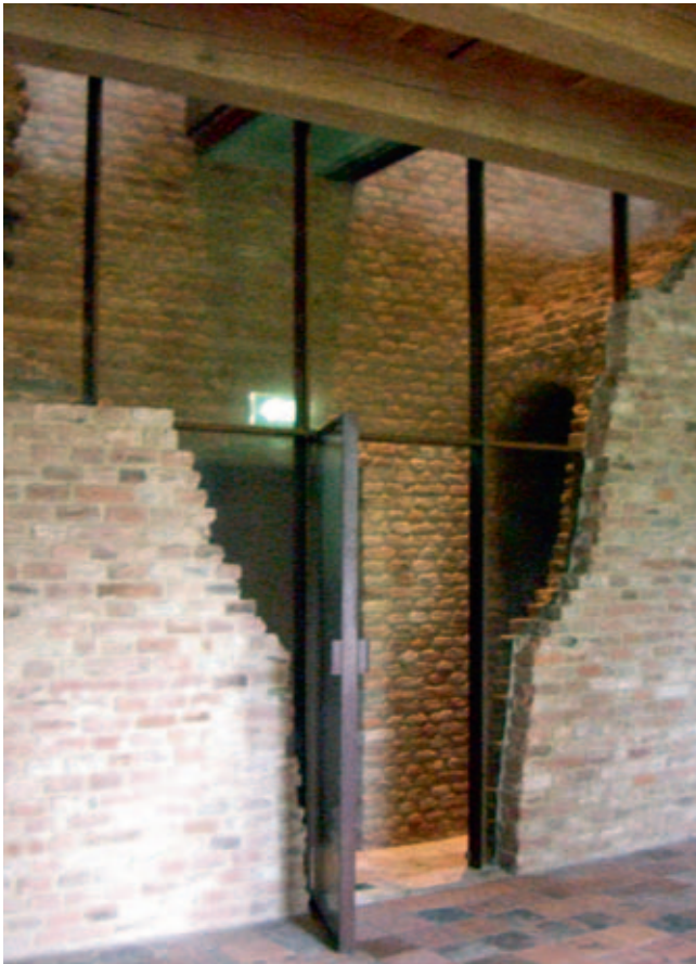
Afb. 7 Ter plaatse van de muurtrappen heeft de architect ervoor gekozen om het vervallen uiterlijk van de binnenmuren te behouden en het muurvlak in hedendaagse vormgeving en materialisering aan te vullen (Kasteel Nederhemert, Nederhemert-Zuid, april 2008)
