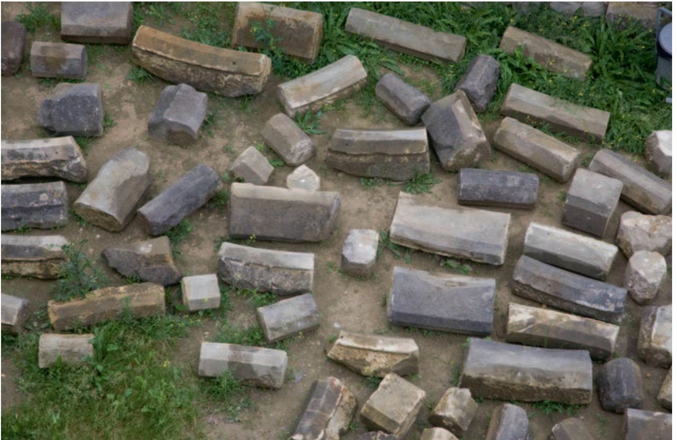
Afb. 7. Rib- en gordelboogstenen van de voormalige overwelling onder de zaal, Valkenburgs Trümmerfeld, bij werkzaamheden in 2008 (foto Ton Penders RCE 2008)
