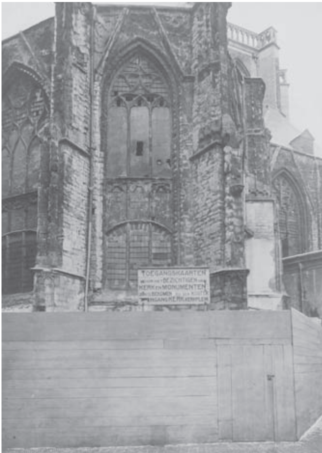
Afb. 2. Oostgevel van de consistorie en 'librije' waarbij de vergaande verwerking van het beeldhouwwerk duidelijk te zien is (foto RDMZ 1905)
