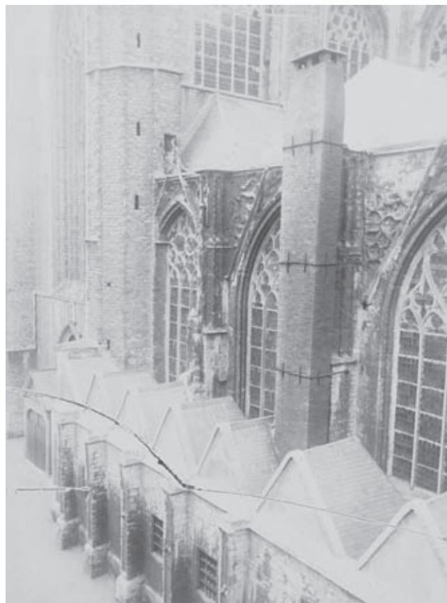
Afb. 4. Zuidgevel van het nieuwe pastoorshuis (foto RDMZ 1888)
