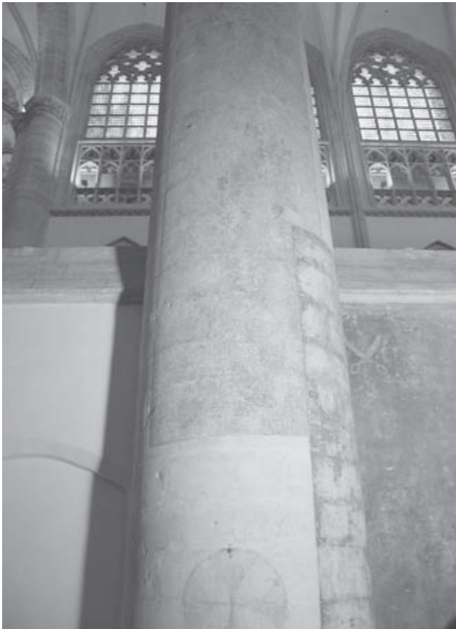
Afb. 5. Westpilaar naast noordwand van de lakenscharenkapel (foto: Leeflang 2006)
