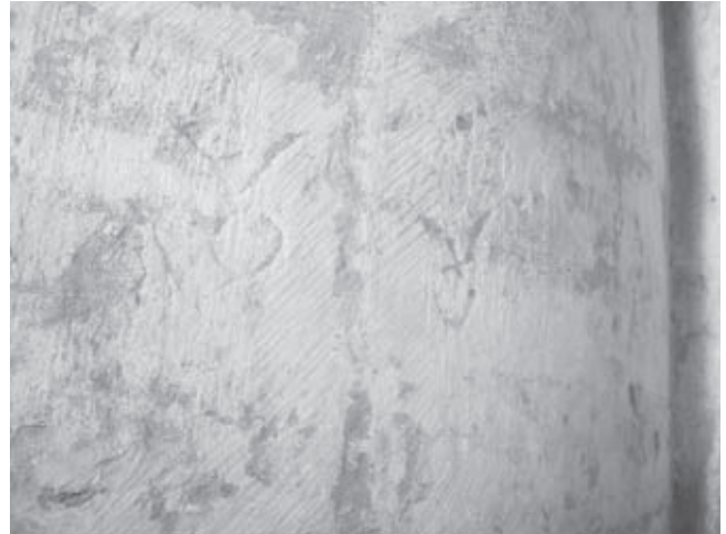
Afb. 6. Ingekraste laagmerken op de linker kolom (westzijde van de lakenscharenkapel, foto: Leeflang 2006)
