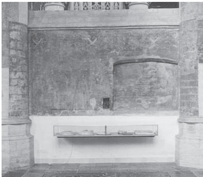
Afb. 1. Grote Kerk Breda, zuidelijke koorwand in de tweede travee van de kooromgang met de lakenscharen, tweede kwart zestiende eeuw (foto: RDMZ 2002)
