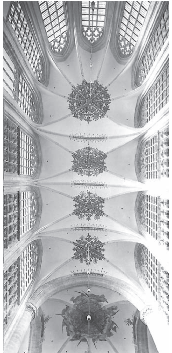
Afb. 2. Gewelfschilderingen hoogkoor, overzicht na de restauratie van 1995-1997 (foto RDMZ 2000)
