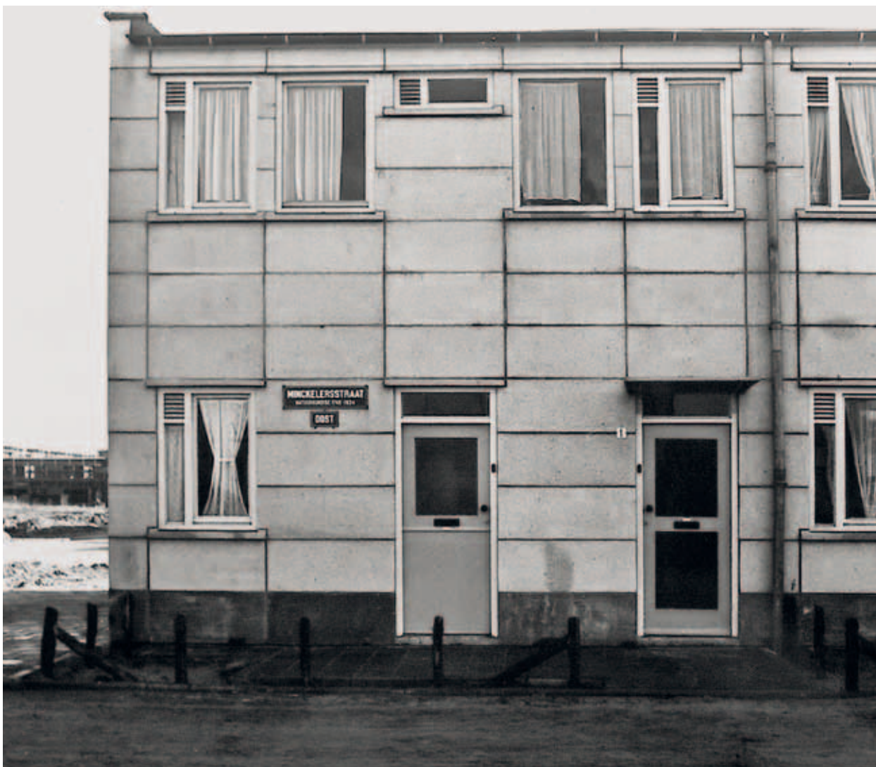
AFB.17. Oorspronkelijke voorgevel in 1953 (Stadsarchief Amsterdam)
