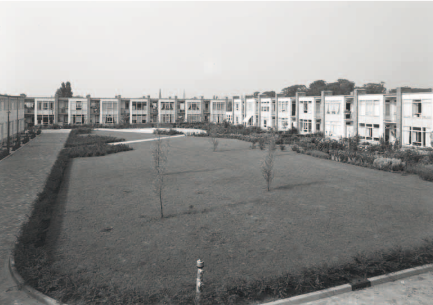
AFB.3. Binnenhof Eijkmanstraat na oplevering in 1951 (Stadsarchief Amsterdam)
