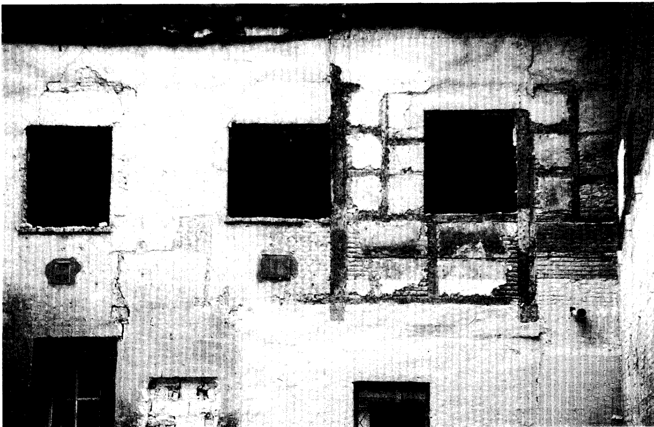
Afb. 2. Maastricht, Vrijthof N.-zijde. Fragment van de gedeeltelijk ontleisterde vakwerkconstructie aan de zuidzijde van de noordelijke pandhofvleugel van het voormalige Witte Vrouwenklooster (foto auteur).
