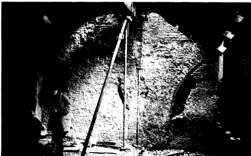
5. Catharinastraat 87 Breda: A. kloostermuur met bogen aan de zijde van het Begijnhof, dichtgezet in de 16de eeuw; B. isometrie van het recent gesloopte voorhuis daterende uit het tweede kwart of het midden van de 16de eeuw (foto en tekening auteur)
