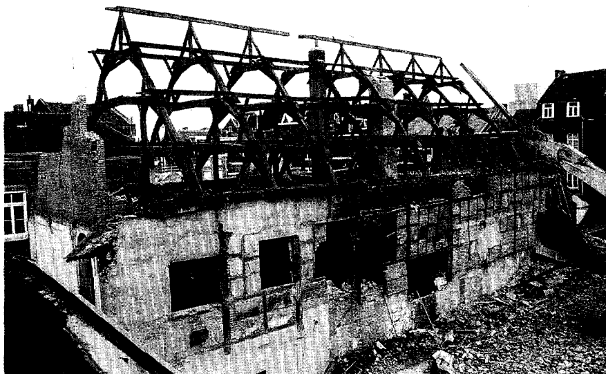
Afb. 3. Idem afb. 2, tijdens de sloop. De zeven traveeën brede vakwerkconstructie op de verdieping boven de voormalige kloostergang dateert uit ca. 1515, de kapconstructie is 17e eeuws (foto auteur).
