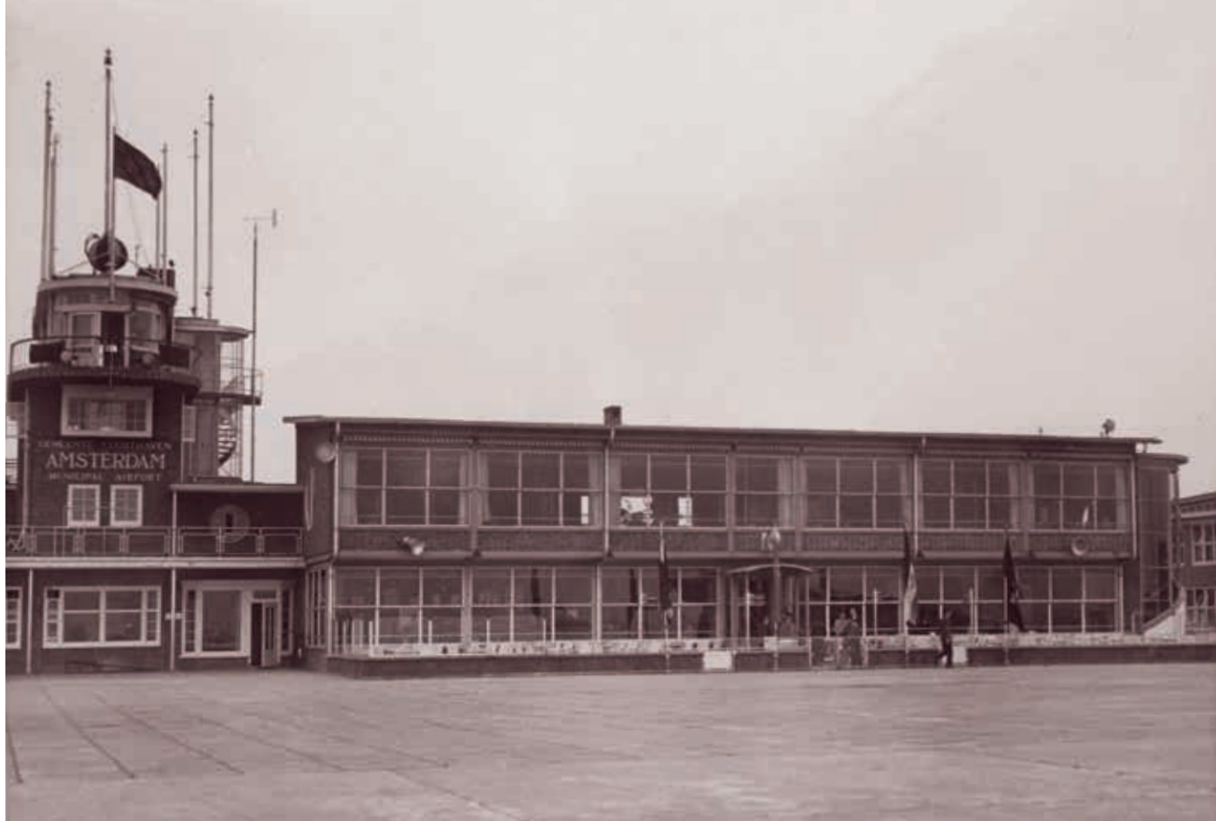
10. Het dakrestaurant op het bestaande restaurant met uiterst rechts de trap die leidde tot het terras aan de luchtzijde, ca. 1938 (SAA)
