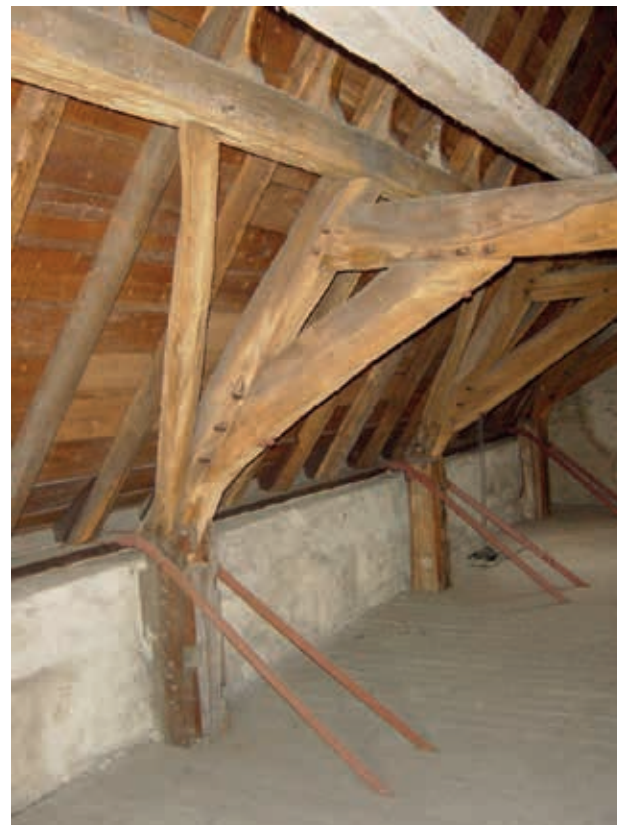
11. Een tussenkalkspant in Vleesstraat 7-9 in Venlo, met aangeheelde voet (foto B. Dukers, 2005)
