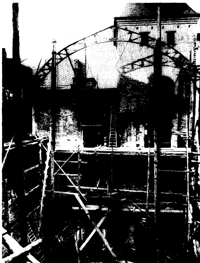
Afb. 10. Het stellen van de spanten van de Monierkap door de werknemers van Paris in november of december 1895. (Collectie kasteel De Haar)
